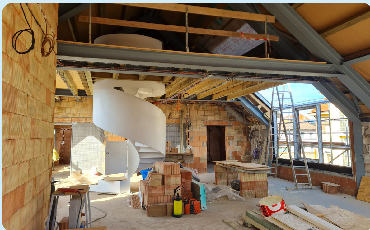
Rekonstrukce a přístavba budovy Mateřské školy Libocká
