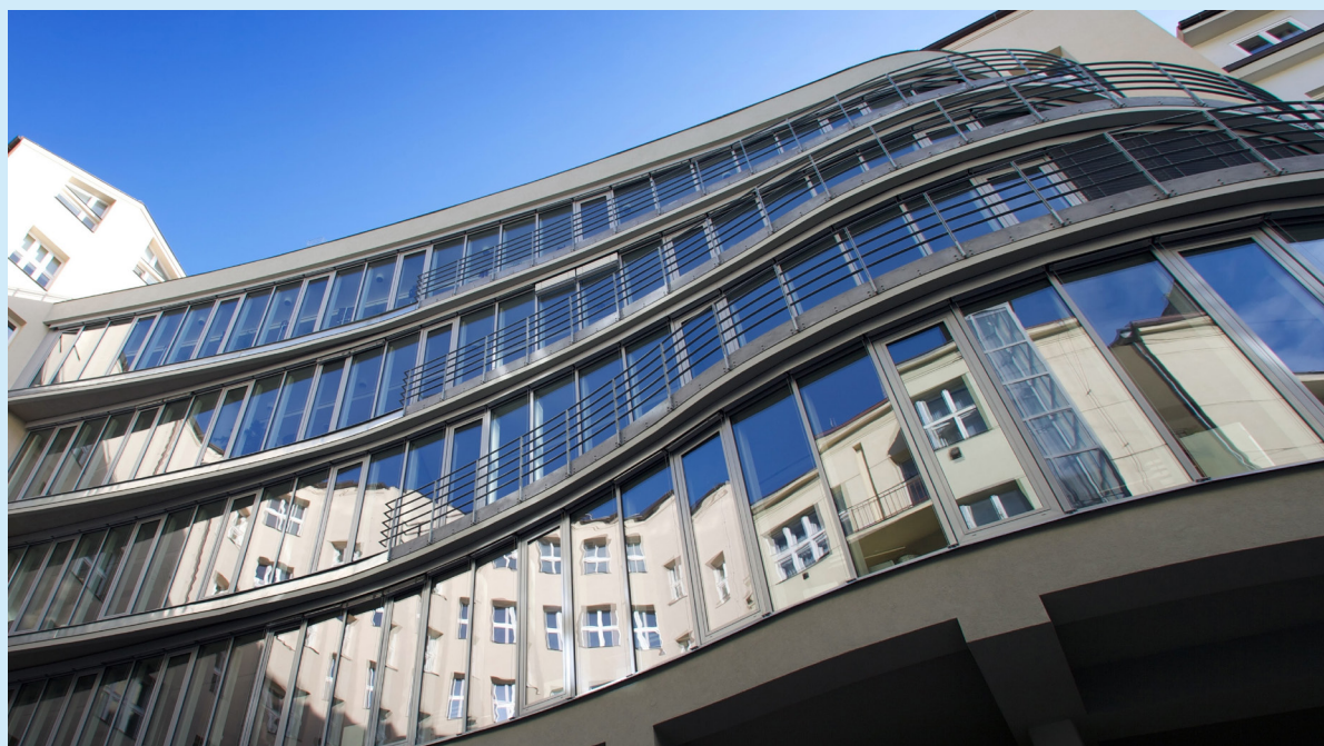
Budova Úřadu městské části Praha 6
