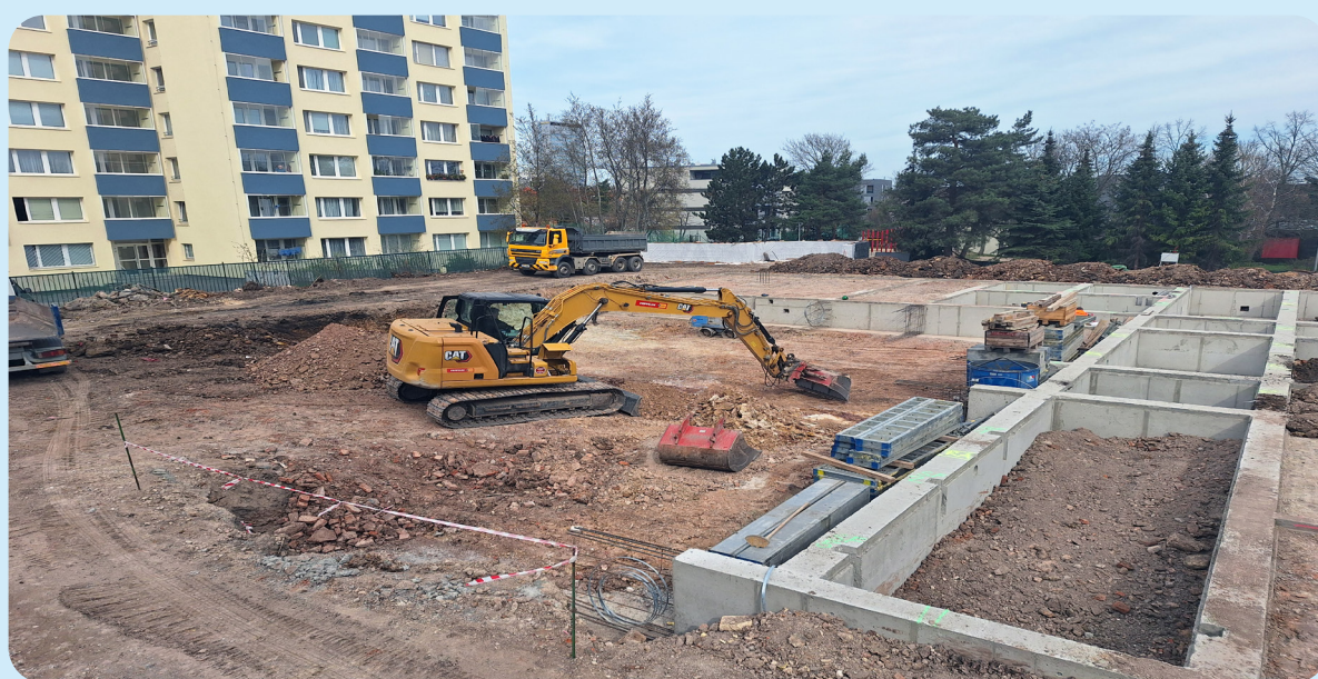
Výstavba budovy Mateřské školy Vokovická
