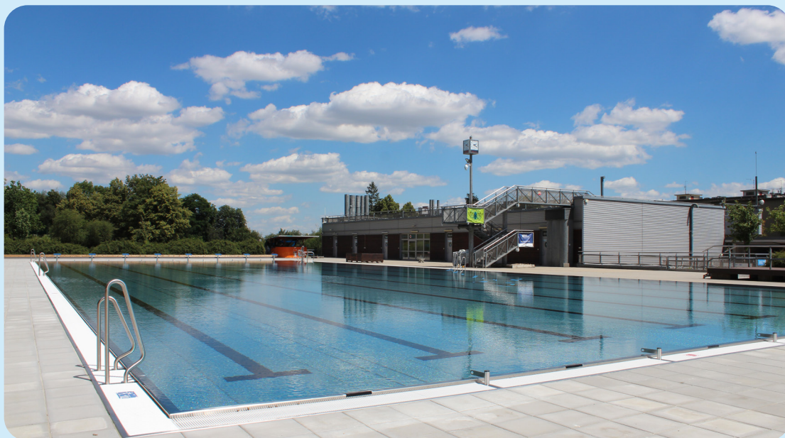
Rekonstruovaný plavecký bazén ve sportovně-rekreačním areálu Petyňka
