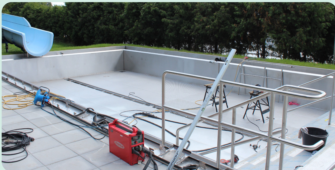
Rekonstrukce bazénů ve sportovně-rekreačním areálu Petynka
