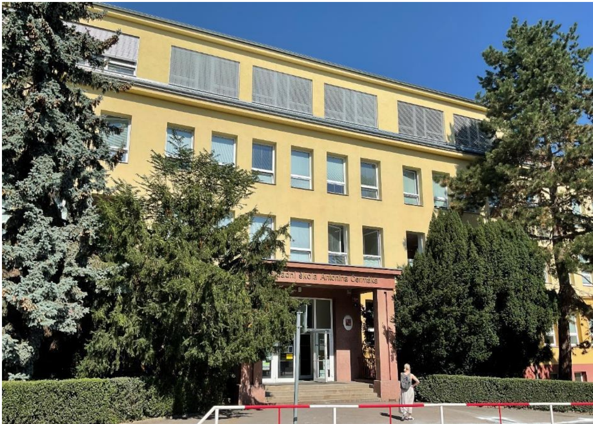
Obrázek 54 Příklad použití vnějších žaluzií (ZŠ Antonína Čermáka)
