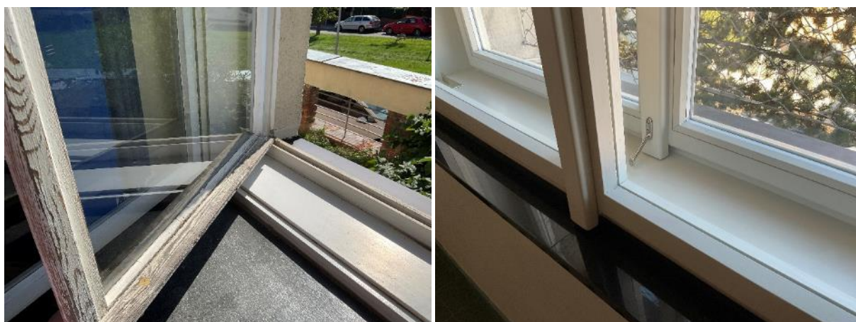
Obrázek 56 Dřevěná okna s rozdílnými tepelně-izolačními vlastnostmi (vlevo – ZŠ Hanspaulka, vpravo – MŠ nám. Svobody 2 v Tychonově ulici)
